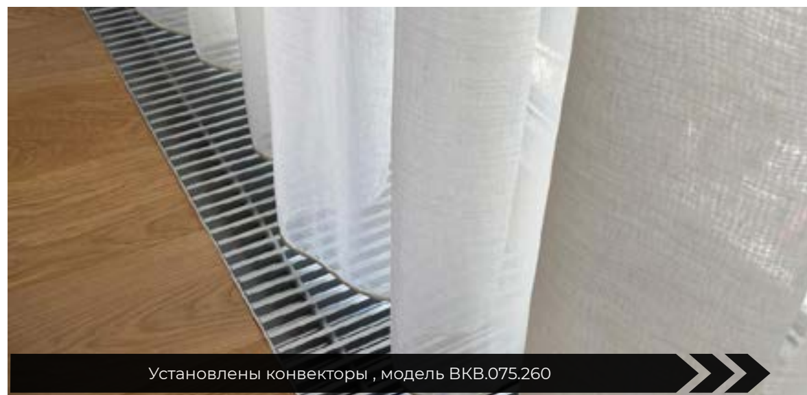
Установлены конвекторы, модель KB.90.258 (прямого, углового исполнения)
