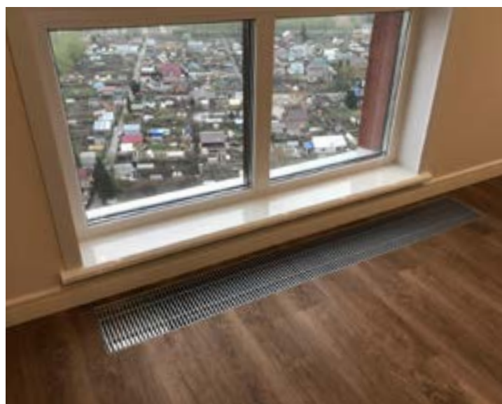
г.Новосибирск. Установлены конвекторы Vitron моделей ВК.90.260 и ВКВ.90.260, решетки Серебро.
