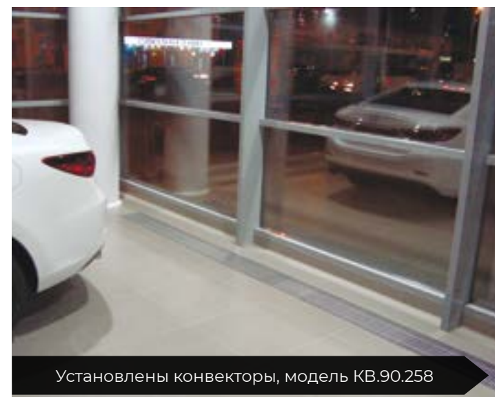
Установлены конвекторы, модель KB.90.258
